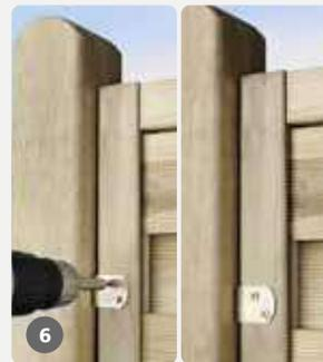
Setze nun die Zaunelemente ein und fixieren diese, nachdem Du die Schraublöcher vorgebohrt hast. Mit zwei Personen ist diese Arbeit, auch ohne Unterlegholz, einfacher zu meistern. Achte auf den gleichmäßigen Pfosten-/Zaunelementabstand von 1 cm, eine gleichmäßige Höhe und die passende Flucht der Zaunfelder.
