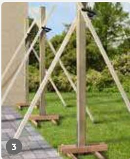
Diagonale Latten helfen Dir, den Pfosten exakt in Höhe und Lot auszurichten. Fixiere diese entweder mit einer Schraubzwinde oder mit Schrauben. Durch den Einsatz einer Spannschnur erreichst Du, dass alle zu setzenden Pfosten in einer Flucht und gerade stehen. Anschließend fülle das Fundamentloch mit Beton. Empfehlenswert ist B25 Fertigbeton, der vorab gründlich angerührt wird.
