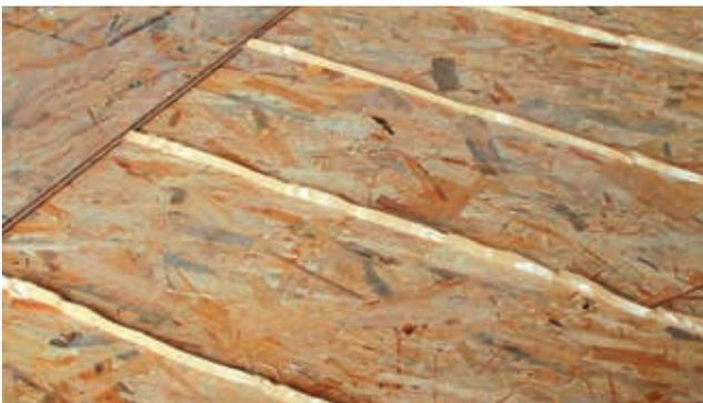
Abbildung 13: Verkleben von OSB mit der Leimpistole
