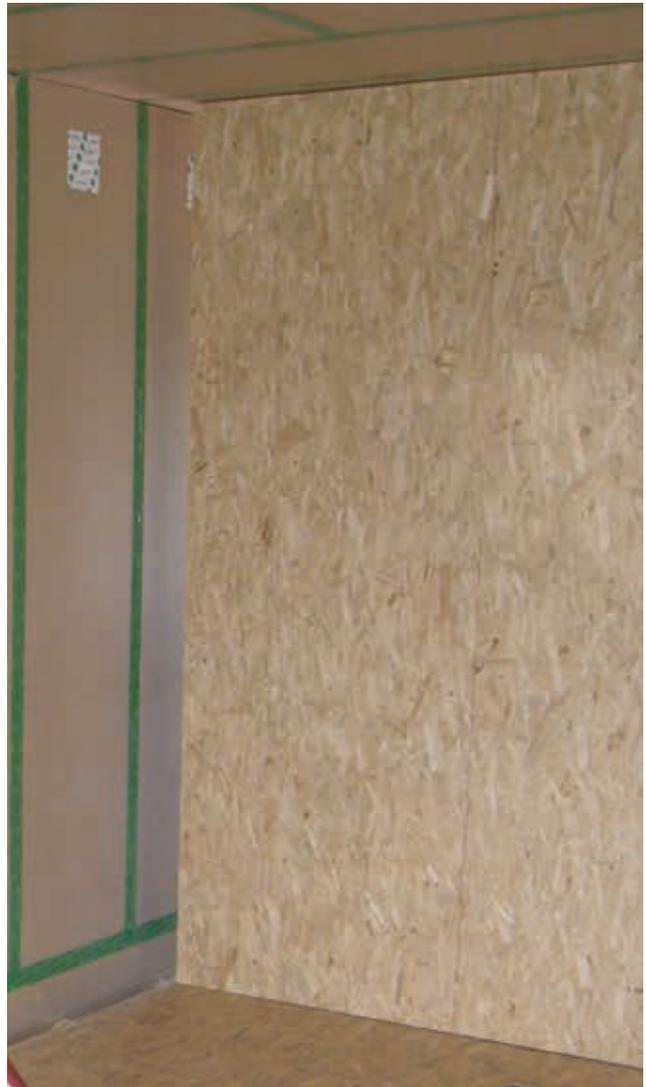
Abb. 18: Bei der Planung wurde die Zahl der Konstruktionsverbindungen zwischen den tragenden Innenwänden und der Außenhülle reduziert. Gleichzeitig ist die luftdichte Hauptschicht während der ganzen Bauphase einfach zu überprüfen. Der Zwischenraum wird nach dem Blower Door Test mit einer zusätzlichen Wärmedämmung ausgefüllt (resultierender  $n_{50}$ -Wert = 0,2 h<sup>-1</sup>).
