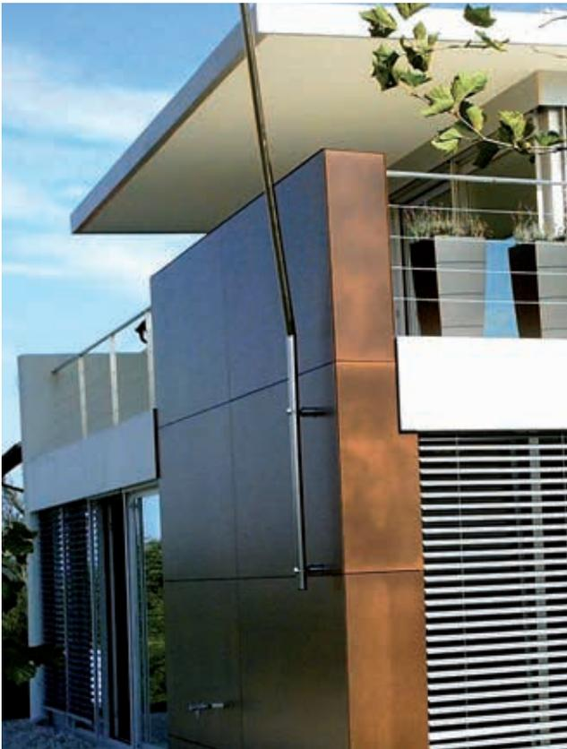
Die unsichtbare mechanische Fassadenkonstruktion ist ein System basierend auf der Befestigung von Kompaktplatten Krono Plan mit Spezialklammern auf einer Unterkonstruktion aus Aluminium.
